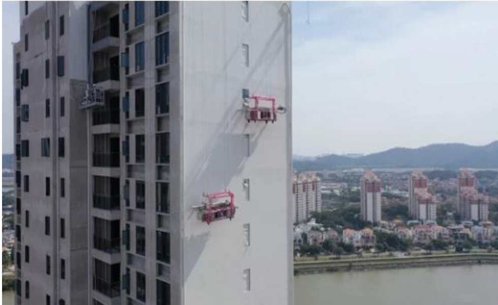
图 4-2 智能建造外墙喷涂机器人实训现场
