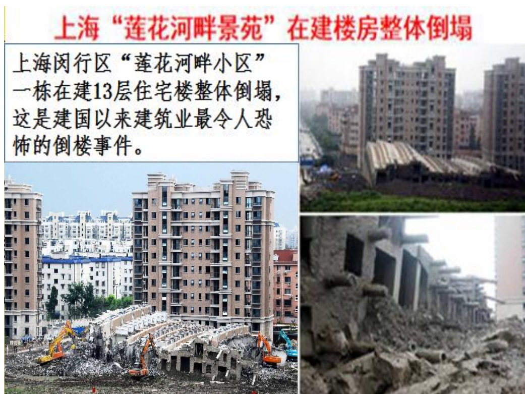
图 2-1 上海“莲花河畔景苑”在建楼房倒塌
